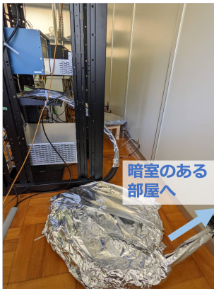
(d) 信号線(計 30 m)の一部とループ部にそれぞれアルミ箔を巻いている。(写真は DAQ 室、4.3.3 節)
