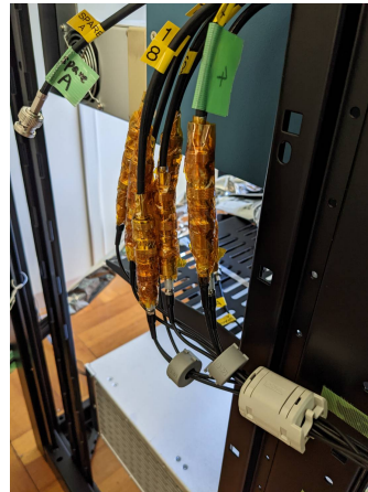
(e) コネクタ部分が電氣的に接続しないようカプトンテープを巻いている。
