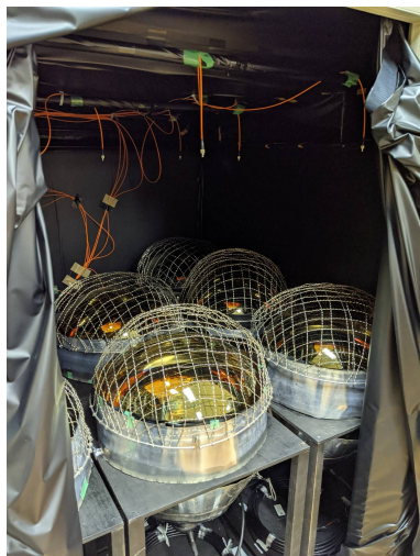
(a) ファイバー固定前。PMT 入れ替作業中にて容易に方向が変わり得る。
